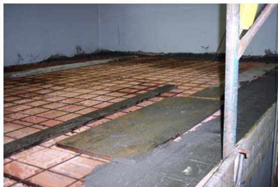
Figura 5 – Le pignatte usate per la realizzazione del solaio (a sinistra) ed il solaio prima del getto della soletta collaborante (a destra)
