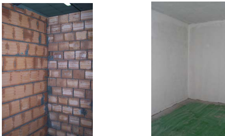
Figura 4 – La parete di prova e la parete laterale prima (a sinistra) e dopo l'intonacatura (a destra)
