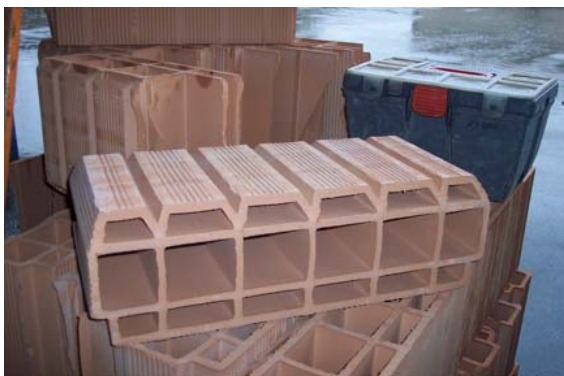
Figura 5 – Le pignatte usate per la realizzazione del solaio (a sinistra) ed il solaio prima del getto della soletta collaborante (a destra)
