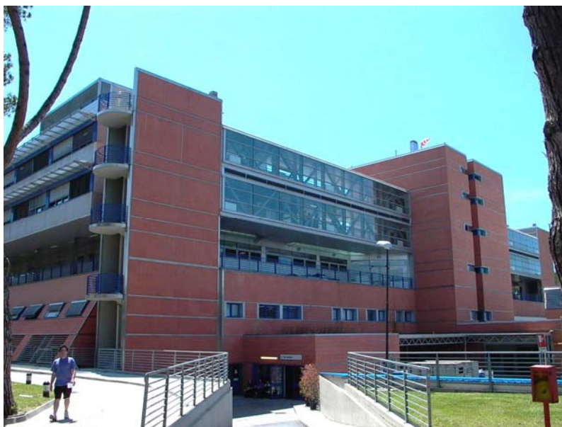
Fig. 2 - Nuovo Ospedale della Versilia: il fronte dell'edificio su cui si attestano i volumi dei servizi tecnologici.
