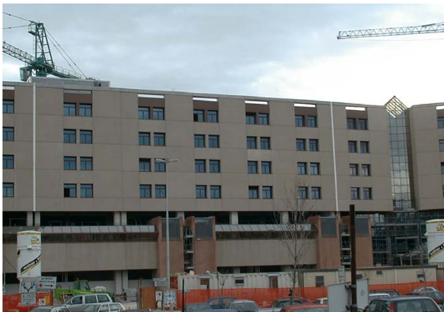
Fig. 4 – Ospedale Torrette di Ancona: un'immagine esterna del fronte dell'edificio che accoglie il blocco operatorio; molto evidente la differenziazione formale tra i piani delle degenze e il piano delle camere operatorie divise dall'interpiano tecnico
